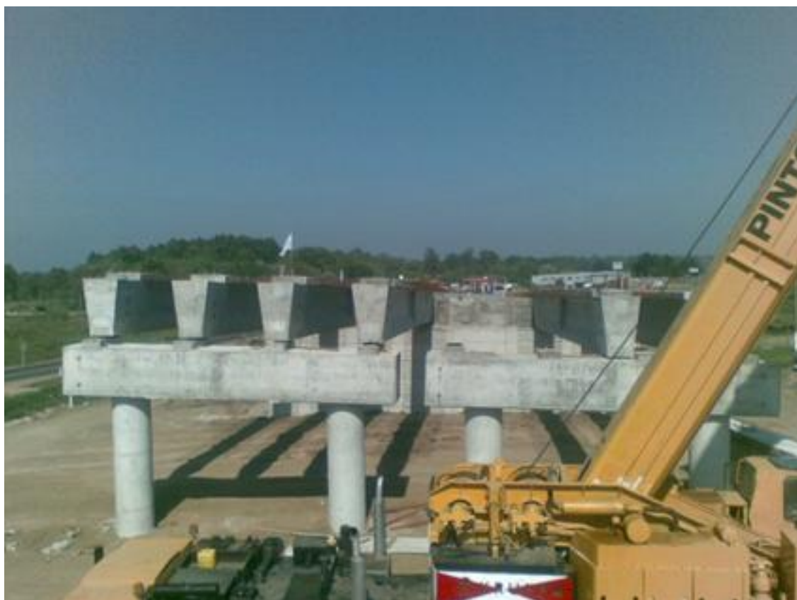
Ilustración 4 - Estructura de hormigón prefabricada
