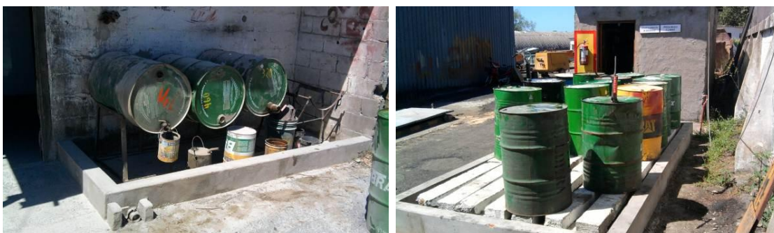
Ilustración 5 - Zona de trabajo con hidrocarburos y su contención
