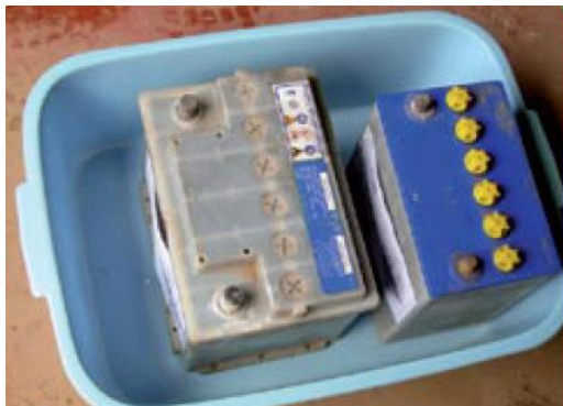
Ilustración 20 - Contenedor para baterías con pérdida de electrolito
