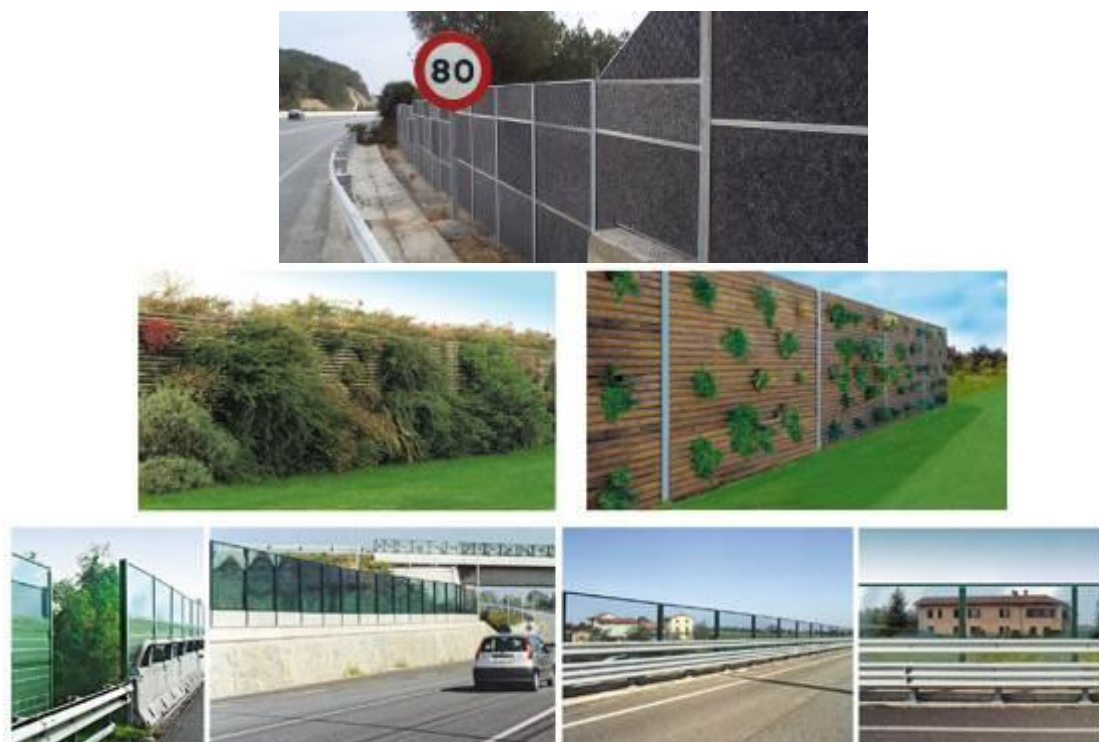
Ilustración 2 - Barreras contra el ruido
