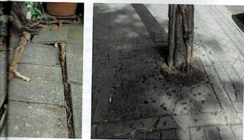
Figura 39. Suelo compactado y severos daños basales.
