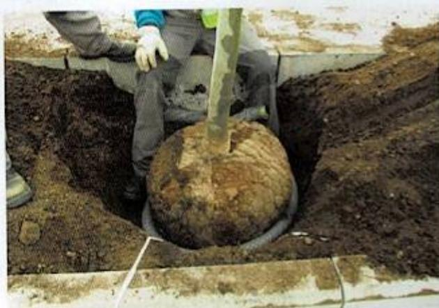
Figura 56. Instalación de tubo de aireación.
