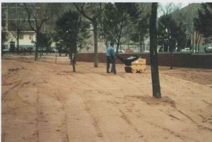
**Foto 9.25.**—Acabado final del terreno, mediante una pasada de rulo, previa a la colocación de los «tepes».
