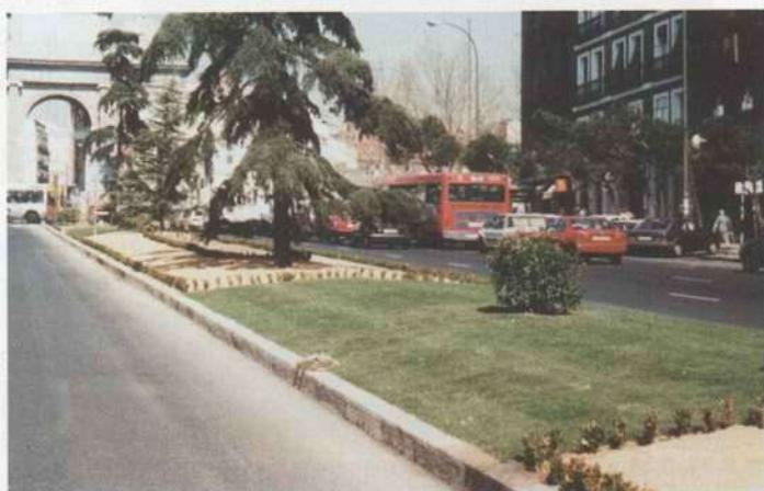
Foto 9.32.—Aspecto final de la obra al terminar una colocación de «tepes».
