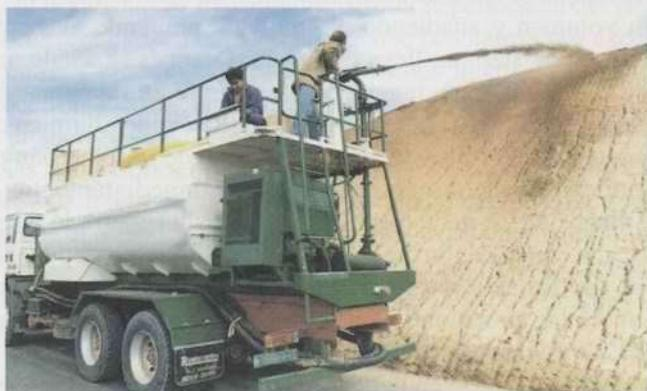
**Foto 9.16.**— Equipo de hidrosembradora en trabajo de siembra en un talud.
