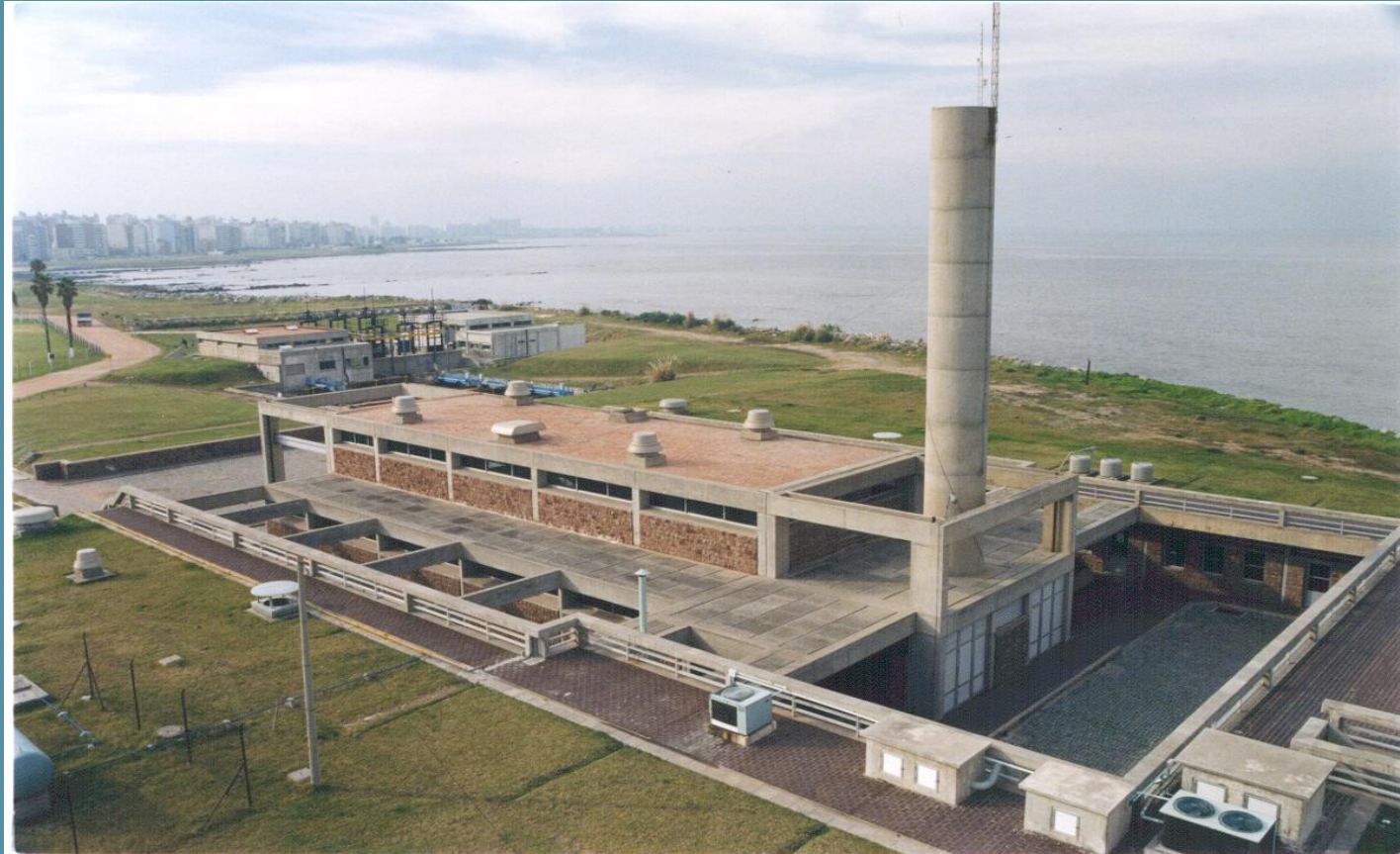
ESTACIÓN DE BOMBEO DE PUNTA CARRETAS
