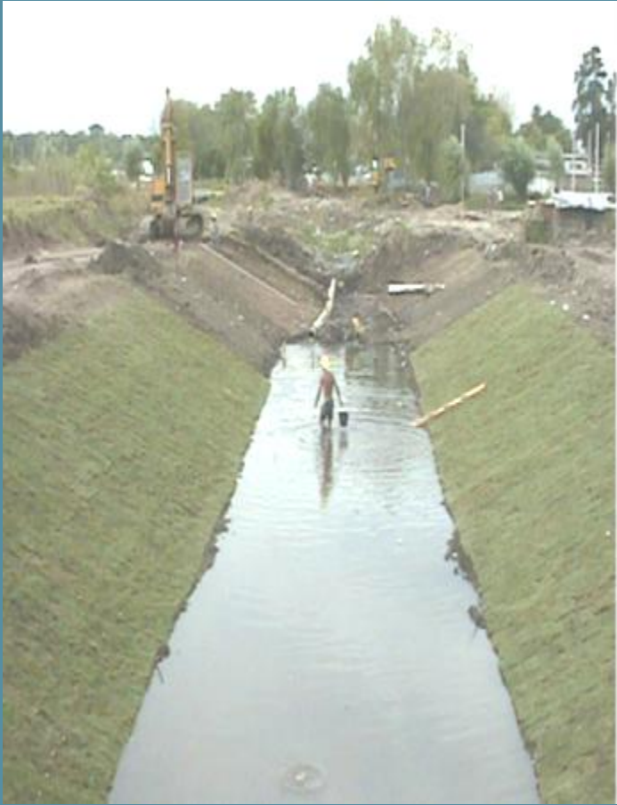
Canales a cielo abierto
